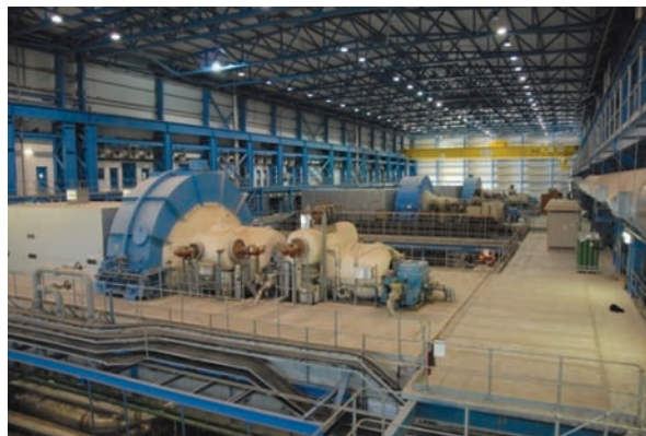
Δωμάτιο γεννητριών Ηλεκτροπαραγωγού Σταθμού Βασιλικού
