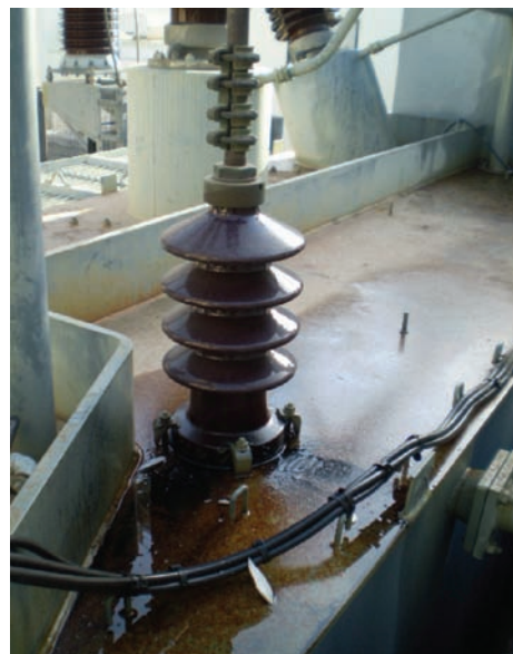
Ο Μετασχηματιστής Αεριοστρόβιλου Αρ.1 στον Ηλεκτροπαραγωγό Σταθμό Μονής μετά τη βλάβη
