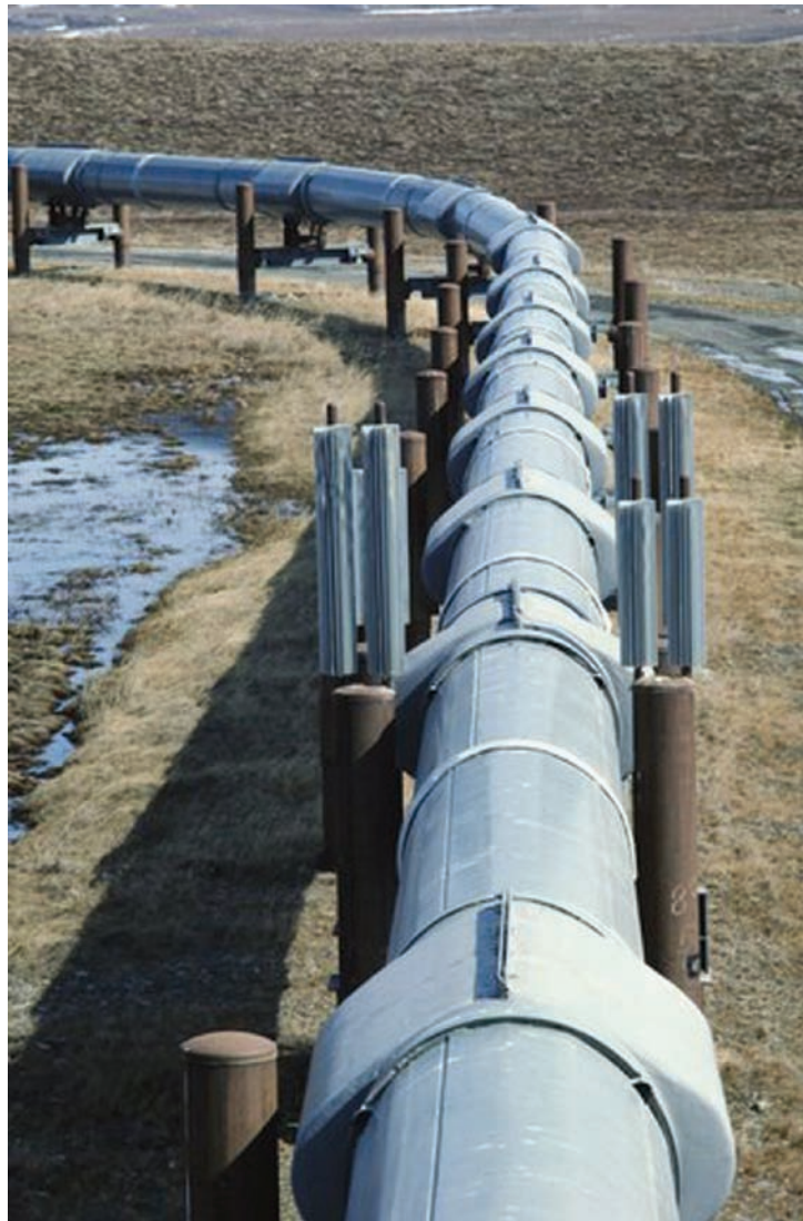
Αγωγός Μεταφοράς Φυσικού Αερίου
