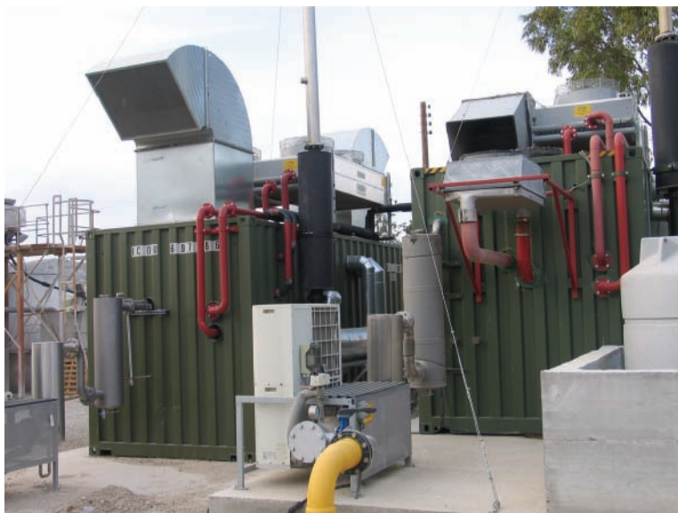
Μονάδα παραγωγής ηλεκτρισμού από βιομάζα / βιοαέριο
