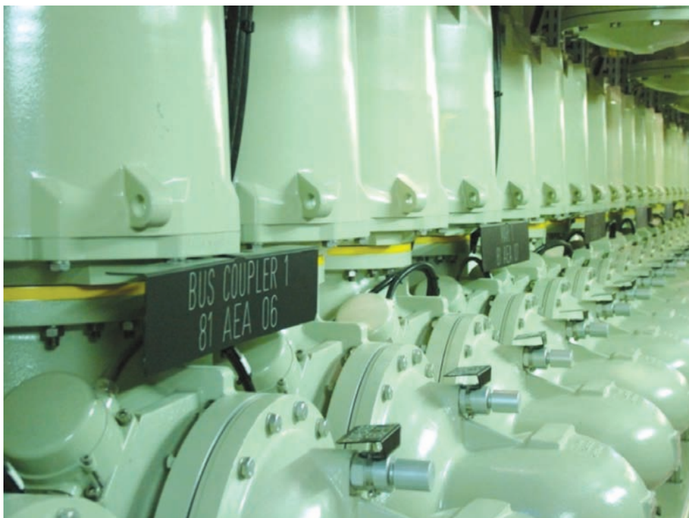
Ο υποσταθμός του Ηλεκτροπαραγωγού Σταθμού Βασιλικού
