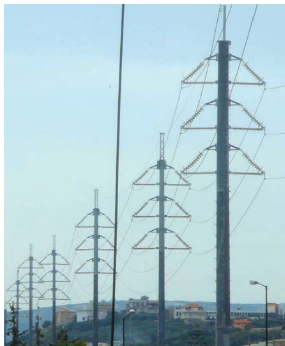
Γραμμή Μεταφοράς 150kV σε μονόστηλα στην Κρήτη
