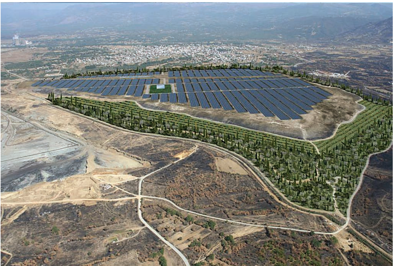
Μεγάλης έκτασης Φωτοβολταϊκό Πάρκο
