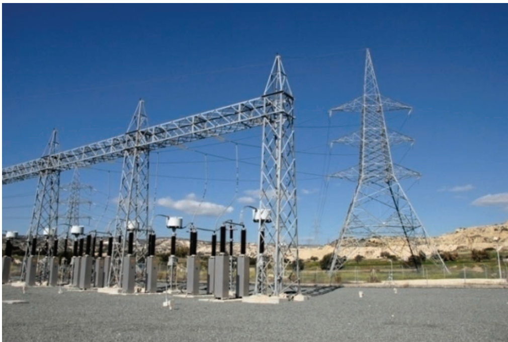
Πύλες αναχωρήσεων 132kV στον Ηλεκτροπαραγωγό Σταθμό Βασιλικού
